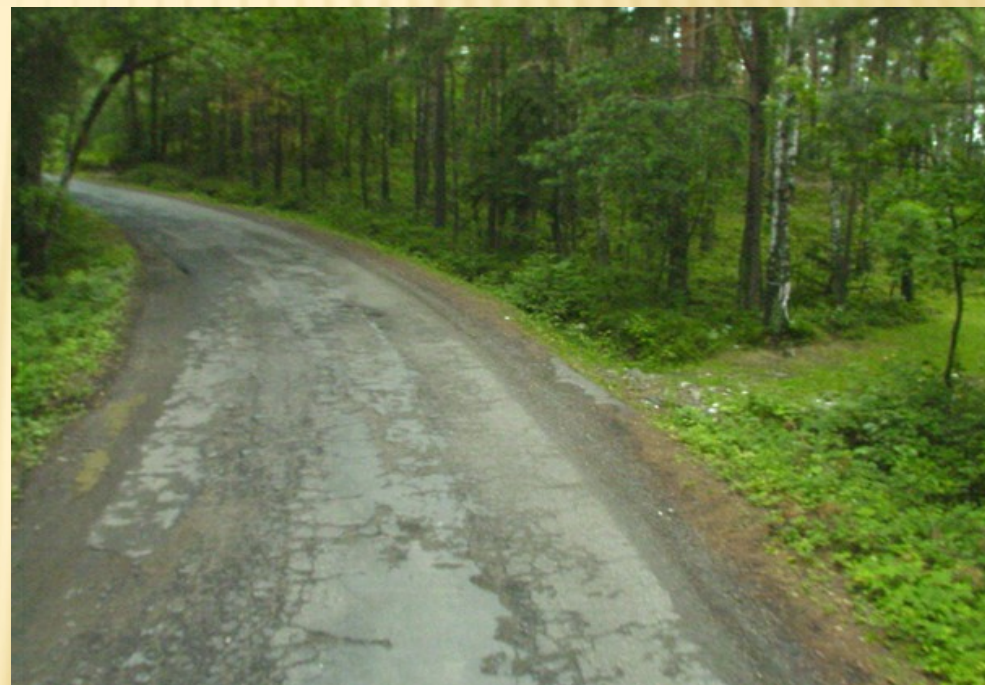
Droga w Rajbrocie przed remontem
