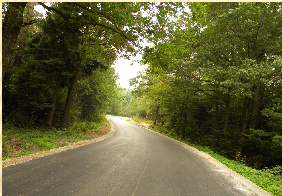
Droga w Rajbrocie po remoncie
