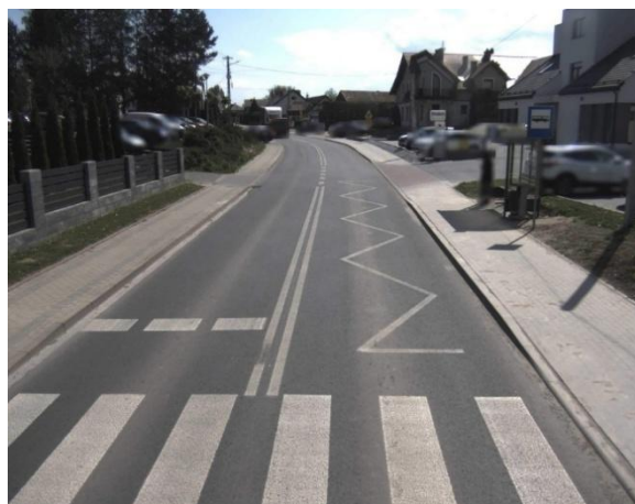
Fot. 37 Odcinek drogi powiatowej nr 2095K po przebudowie drogi w miejscowości Trzciana
