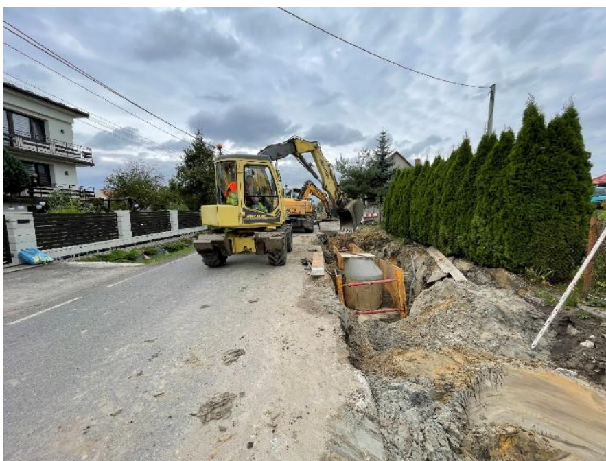
Fot. 46 Rozbudowa drogi powiatowej nr 1442K Krzczów – Grądy w miejscowości Jodłówka.
