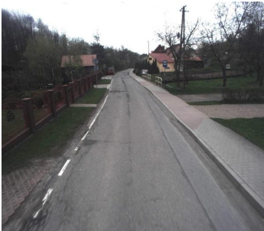
Fot. 62 Odcinek powiatowej nr 2072K przed remontem drogi w miejscowości Kamionna
