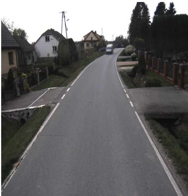
Fot. 44 Odcinek drogi powiatowej nr 1444K przed rozbudową drogi w miejscowości Stary Wiśnicz
