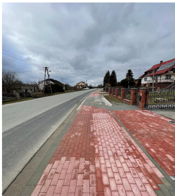
Fot. 45 Odcinek drogi powiatowej nr 1444K po rozbudowie drogi w miejscowości Stary Wiśnicz
