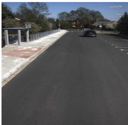
Fot. 53 Odcinek drogi powiatowej nr 2094K po rozbudowie drogi w miejscowości Okulice.
