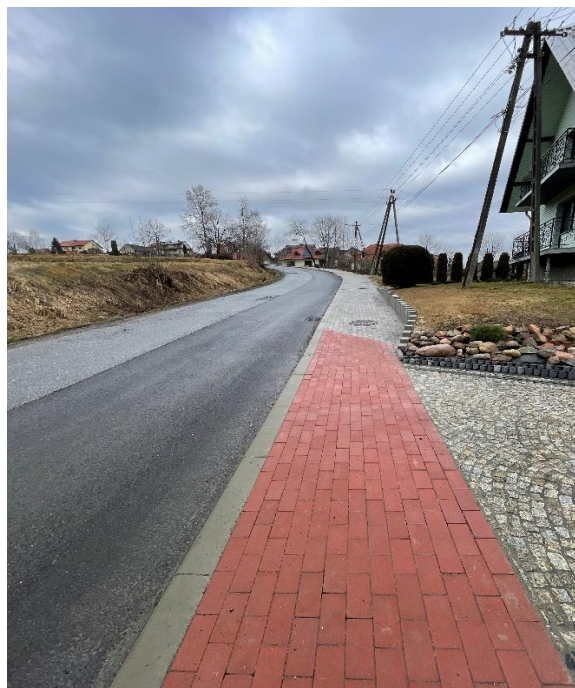
Fot. 59 Odcinek drogi powiatowej nr 1447K po budowie chodnika w miejscowości Rajbrot
