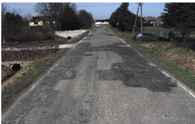
Fot. 50 Odcinek drogi powiatowej 1424K przed rozbudową drogi w miejscowości Słomka
