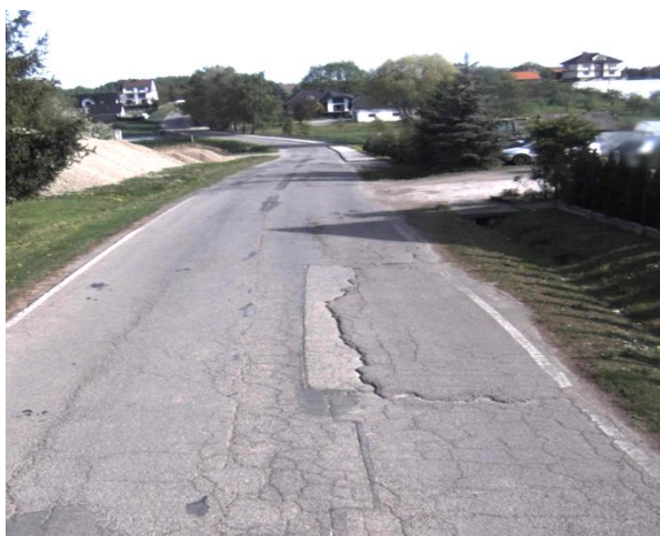
Fot. 48 Odcinek drogi powiatowej 2081K przed przebudową drogi w miejscowości Leszczyna
