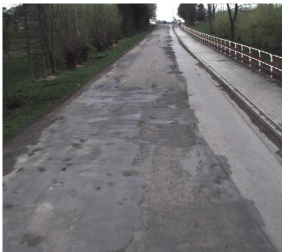
Fot. 38 Odcinek drogi powiatowej 2072K przed przebudową drogi w miejscowości Kamionna
