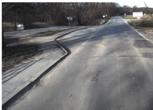
Fot. 56 Odcinek drogi powiatowej 1444K przed przebudową
