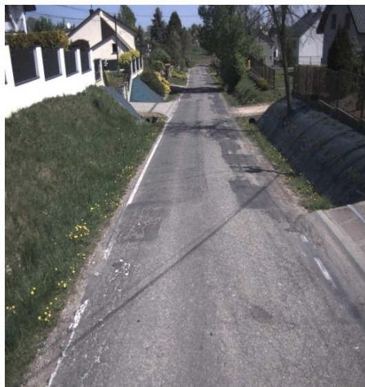
Fot. 66 Odcinek drogi powiatowej nr 2087K przed remontem drogi w miejscowości Łazy
