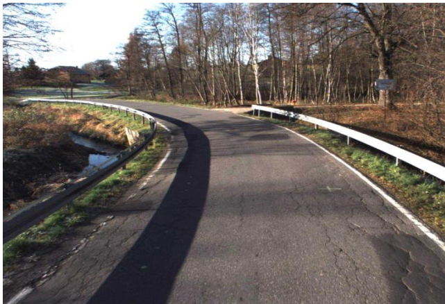
Fot. 42 Odcinek drogi powiatowej 1444K przed przebudową drogi w miejscowości Olchawa
