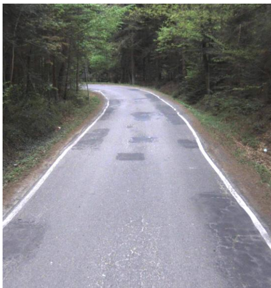
Fot. 60 Odcinek drogi powiatowej nr 2000K
