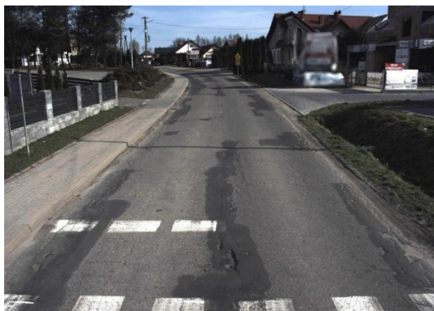
Fot. 36 Odcinek drogi powiatowej 2095K przed przebudową drogi w miejscowości Trzciana
