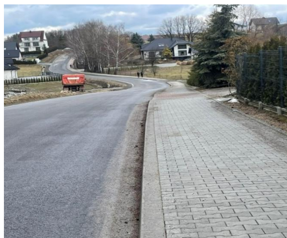
Fot. 49 Odcinek drogi powiatowej nr 2081K po przebudowie w miejscowości Leszczyna
