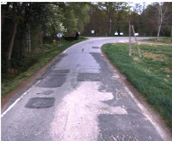
Fot. 33 Odcinek drogi powiatowej 1444K przed rozbudową drogi w miejscowości Nieprześnia
