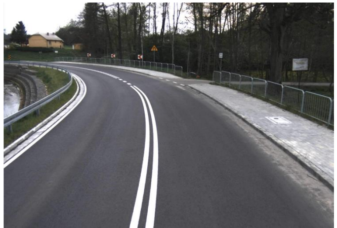
Fot. 43 Odcinek drogi powiatowej nr 1444K po przebudowie drogi w miejscowości Olchawa
