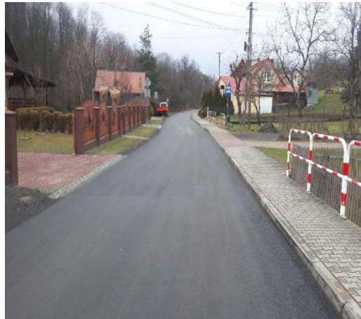
Fot. 63 Odcinek powiatowej nr 2072K po remoncie drogi w miejscowości Kamionna
