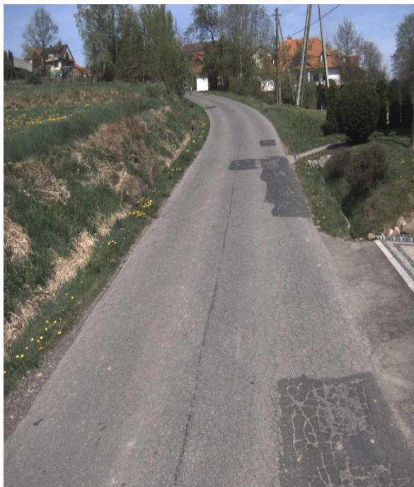
Fot. 58 Odcinek drogi powiatowej nr 1447K przed budową chodnika w miejscowości Rajbrot.
