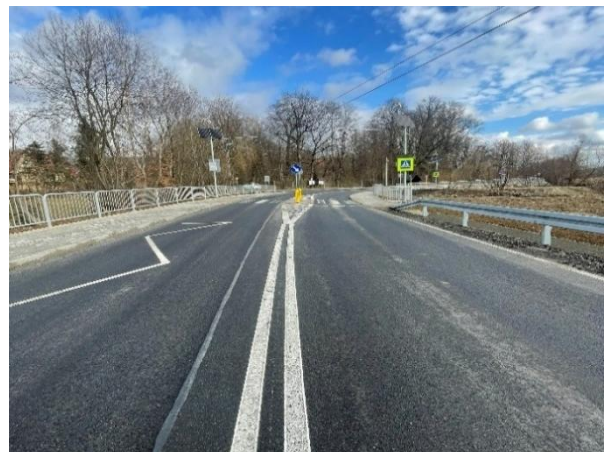
Fot. 34 Odcinek drogi powiatowej nr 1444K po rozbudowie drogi w miejscowości Nieprześnia
