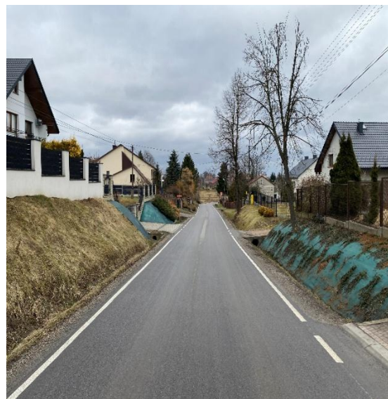
Fot. 67 Odcinek drogi powiatowej nr 2087K po remoncie drogi w miejscowości Łazy
