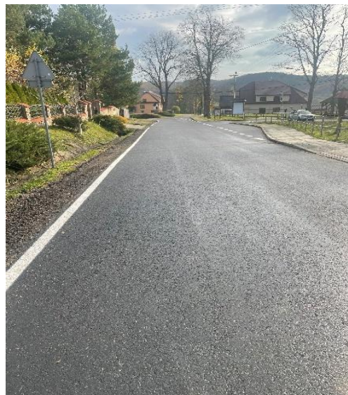
Fot. 65 Odcinek powiatowej nr 2078K po remoncie drogi w miejscowości Borówna
