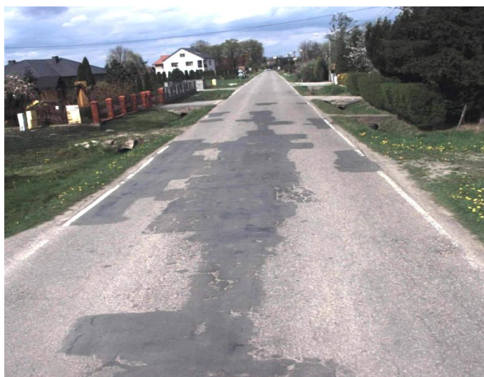
Fot. 40 Odcinek drogi powiatowej nr 1424K w miejscowości Słomka przed rozbudową
