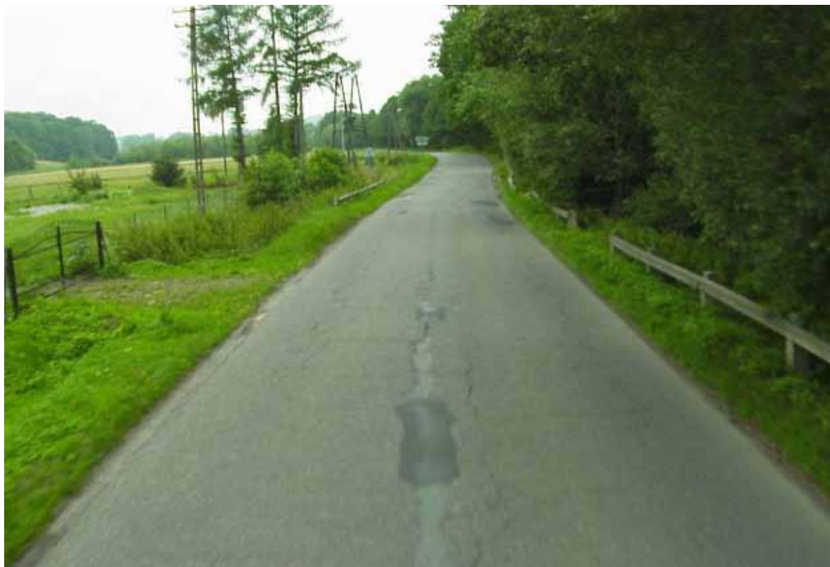
Droga 1444 K w m. Stary Wiśnicz przed przebudową.
