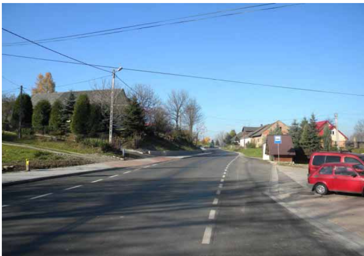
Droga 1444 K w m. Chrostowa po przebudowie.
