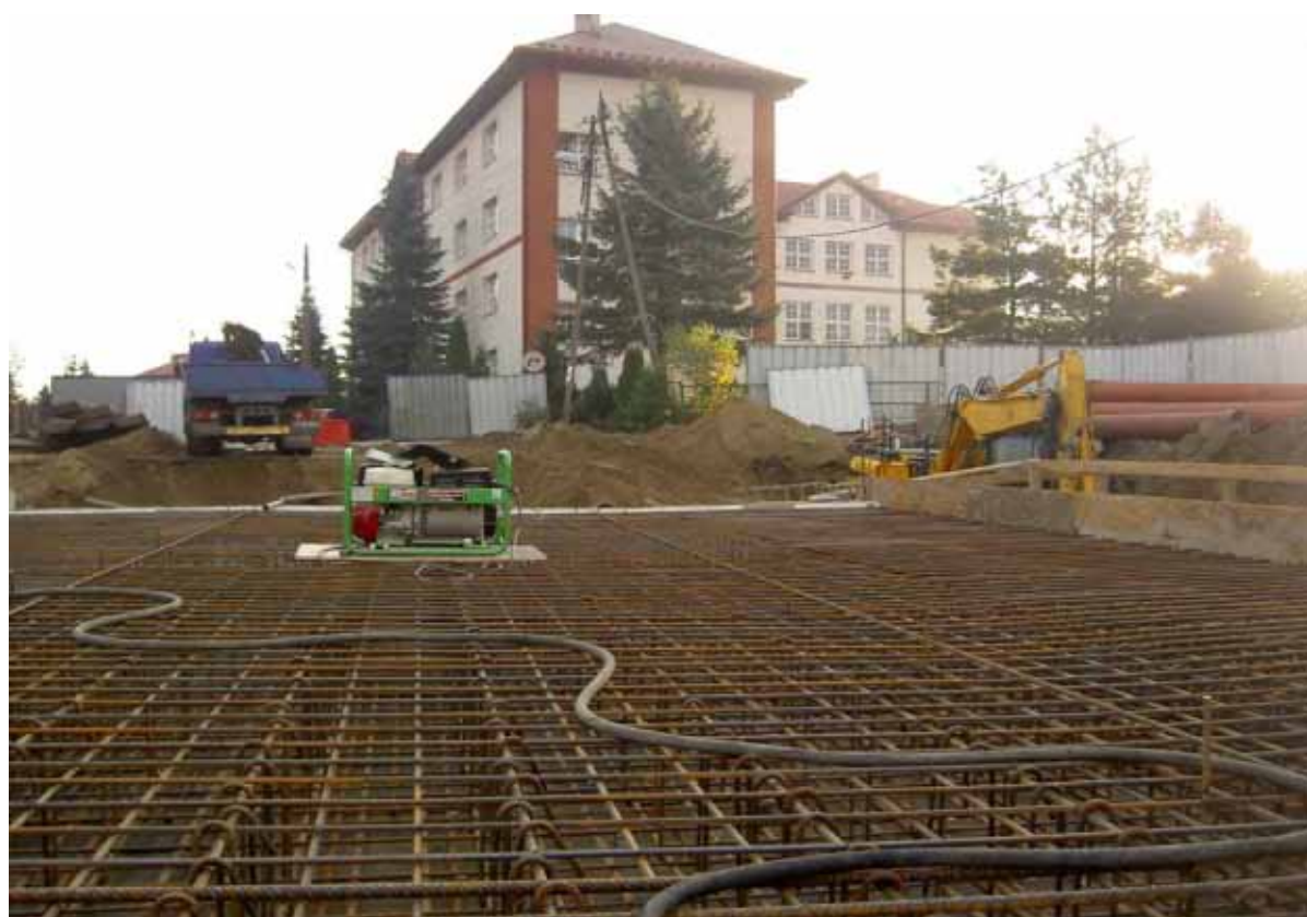
Zbrojenie płyty mostu
