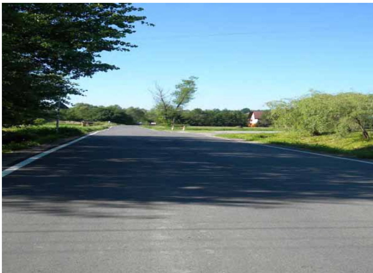
Droga 2082 K w m. Królówka po przebudowie.
