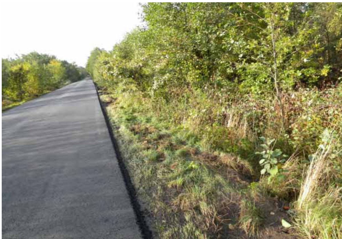
Remont drogi powiatowej nr 1428K Bochnia – Niedzielska w msc. Dąbrówka w km. 7+640 – 8+095 - w trakcie wykonywania
