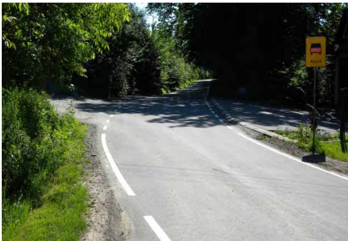
Droga 2071 K w m. Zbydniów po przebudowie.
