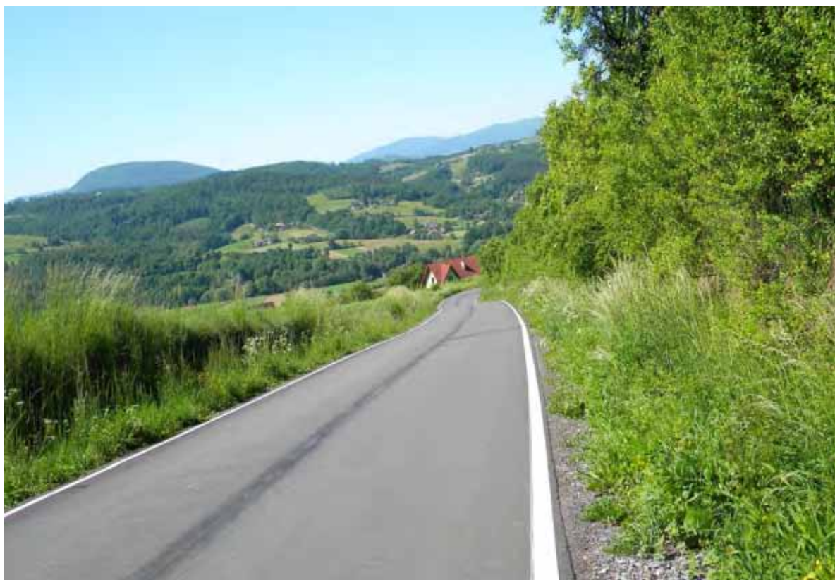
Droga 2071 K w m. Zbydniów po przebudowie.
