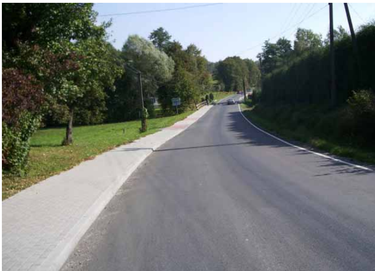
Droga 1444 K m. Olchawa po przebudowie.
