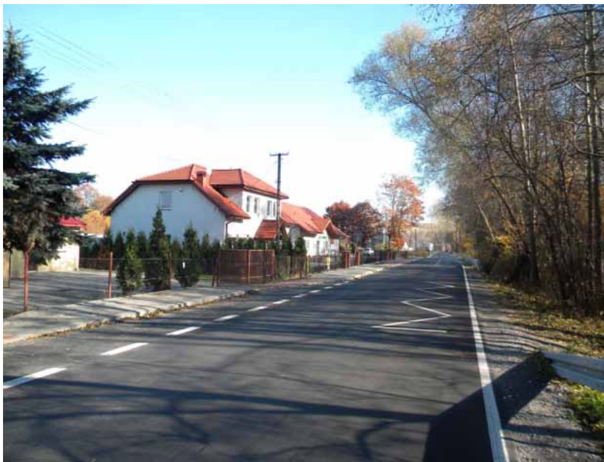
Droga 1444 K w m. Stary Wiśnicz po przebudowie.
