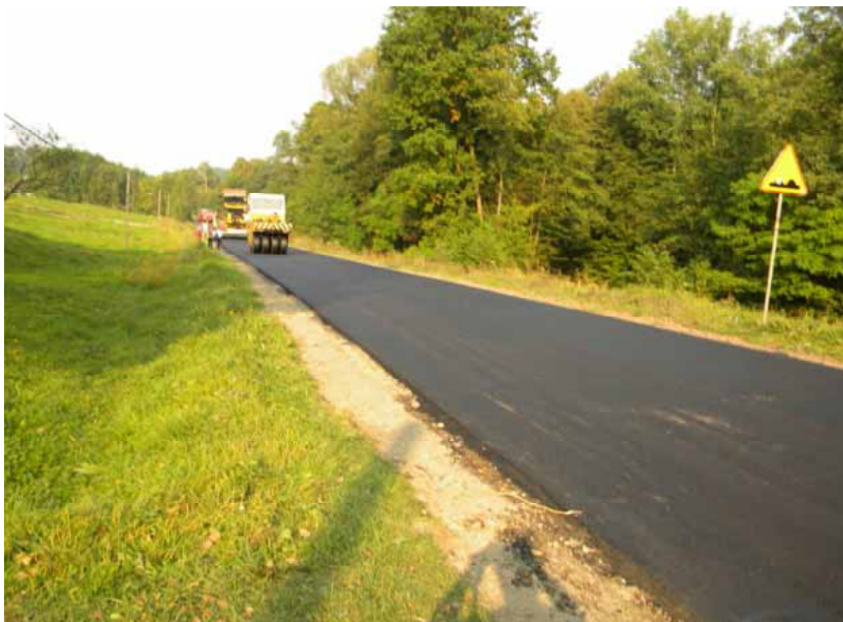
Remont drogi powiatowej nr 2078K Kobyle – Lipnica Górna w w km. 3+087 – 3+287 - w trakcie wykonywania.
