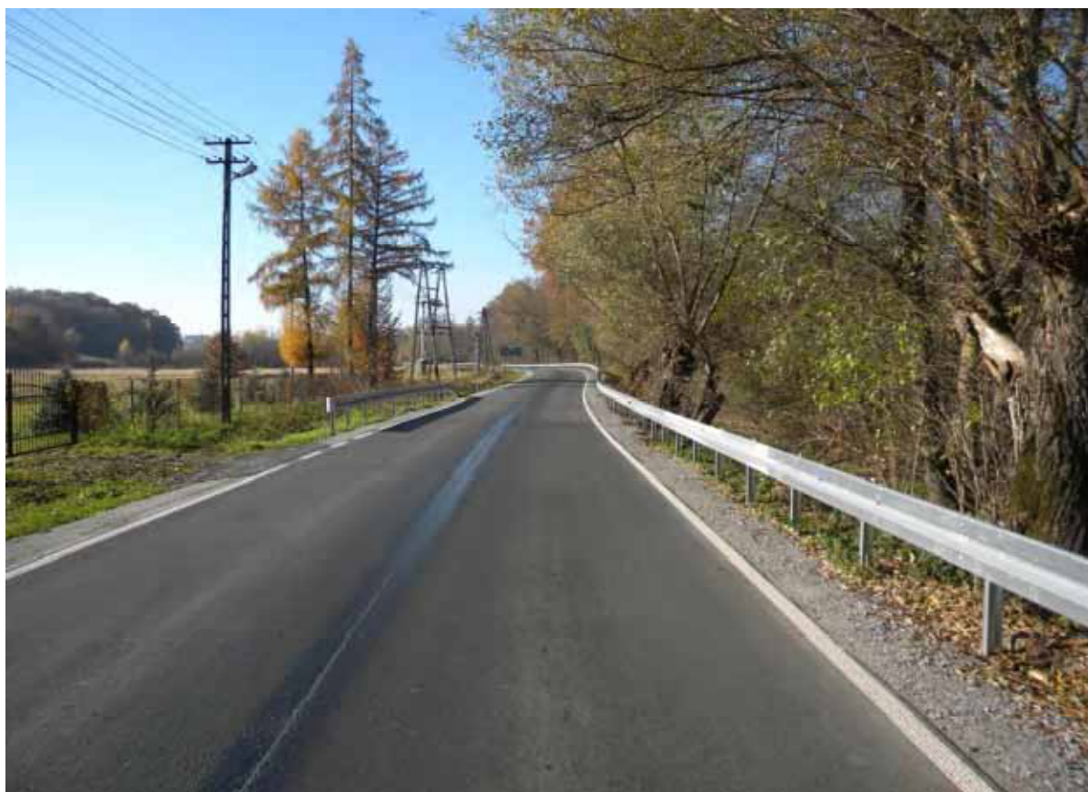
Droga 1444 K w m. Stary Wiśnicz po przebudowie.
