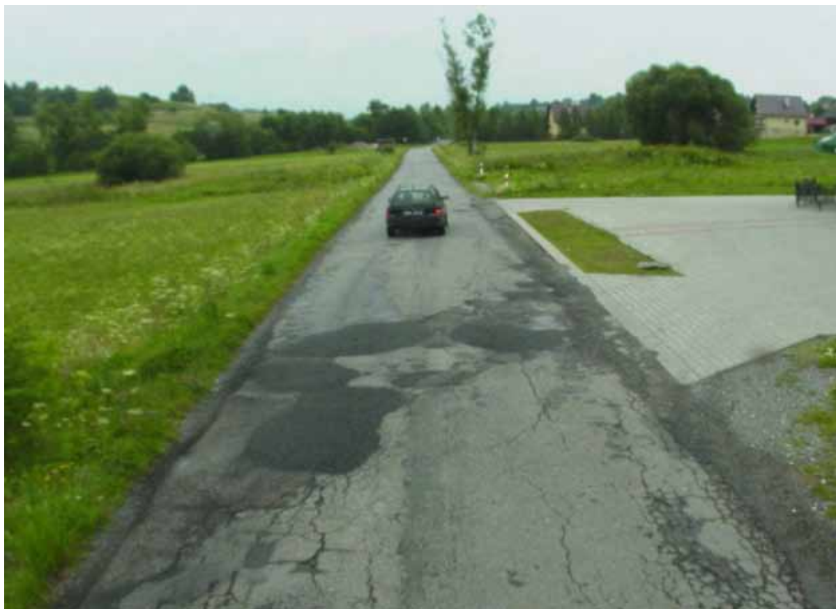
Droga 2082 K w m. Królówka przed przebudową.
