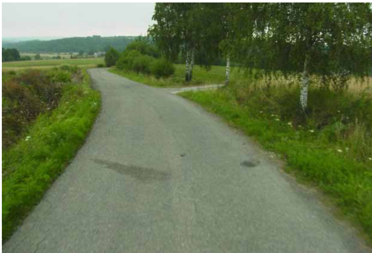
Remont drogi powiatowej nr 2079K Nowy Wiśnicz – Chronów msc. Łomna w km. 2+900 – 3+580 – przed wykonaniem
