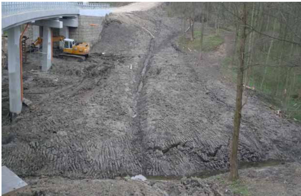
Zabezpieczenie i umocnienie nasypu skarpy przy drodze powiatowej nr 2072K Leszczyna – Nowe Rybie w msc. Kamionna.
