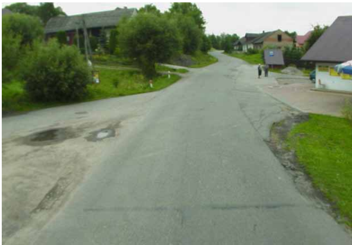
Droga 1444 K w m. Chrostowa przed przebudową.
