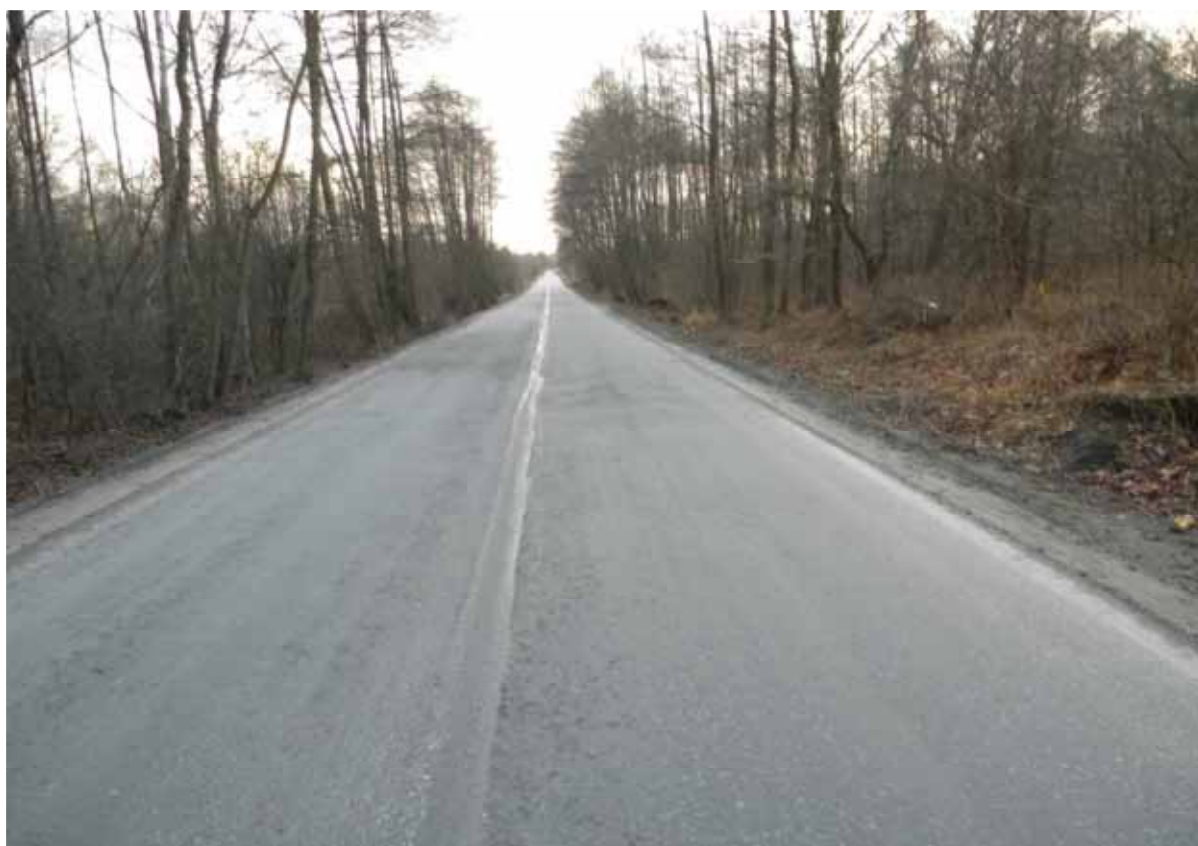
Remont drogi powiatowej nr 1428K Bochnia – Niedzielska w msc. Dąbrówka w km. 7+64 – 8+095 – po wykonaniu
