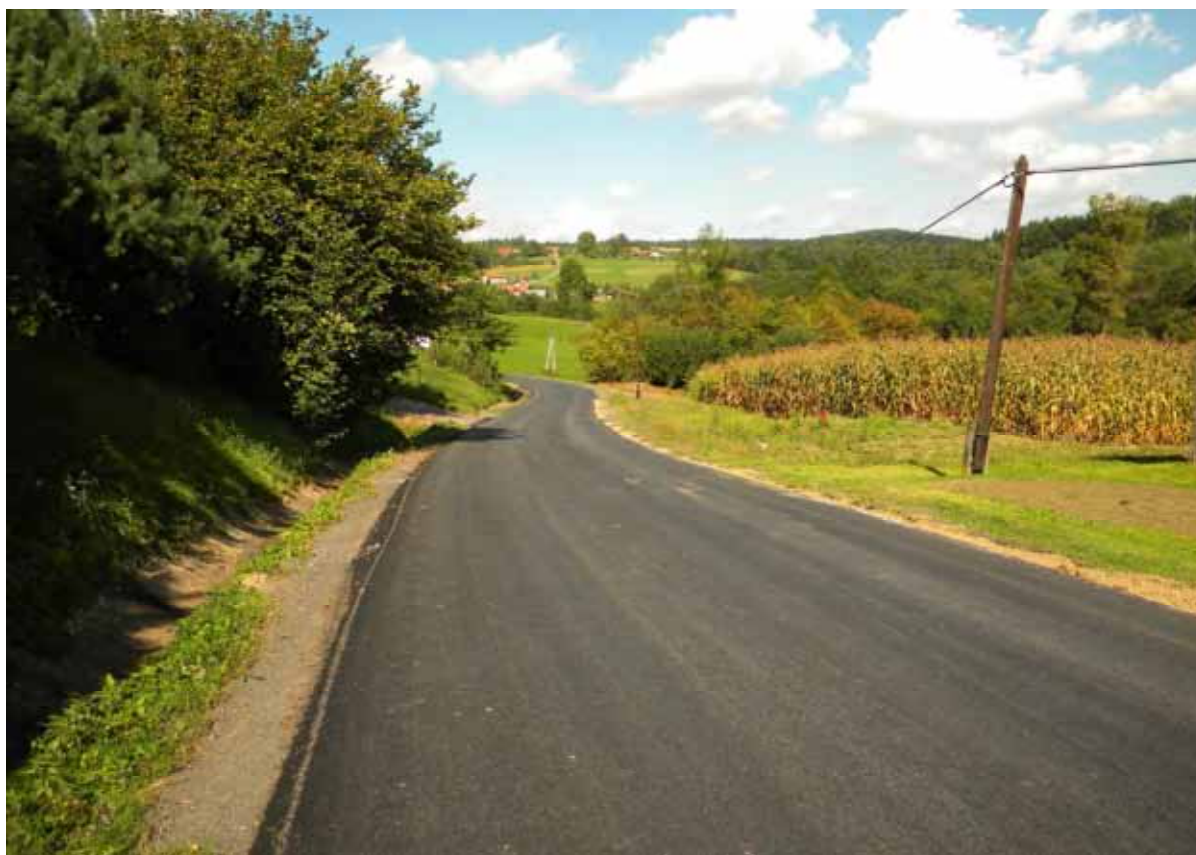
Remont drogi powiatowej nr 2017K Brzezie – Marszowice – Łapanów w msc. Kobylec w km. 2+330 – 3+ 010 - w trakcie wykonywania
