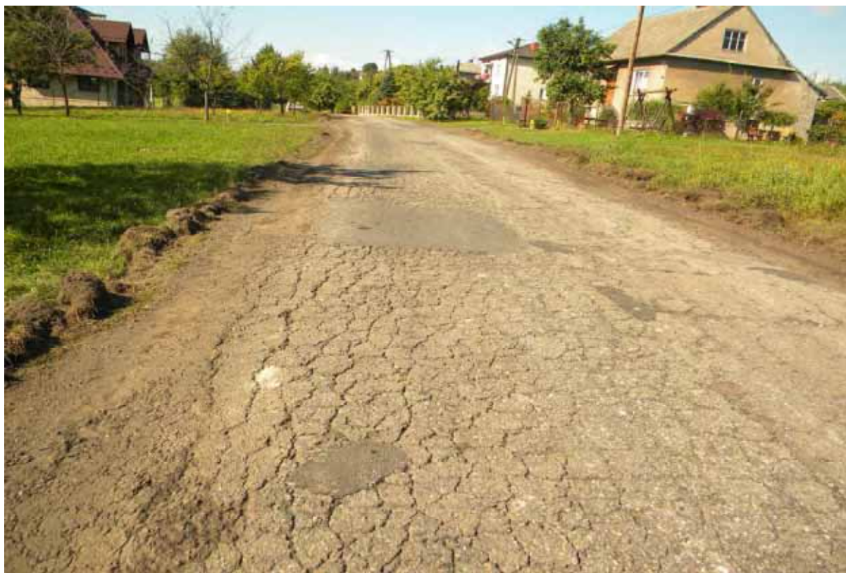
Remont drogi powiatowej nr 2076K Połom Duży- Lipnica Murowana w msc. Połom /Lipnica Górna w km. 3+900 – 4+735 – przed wykonaniem
