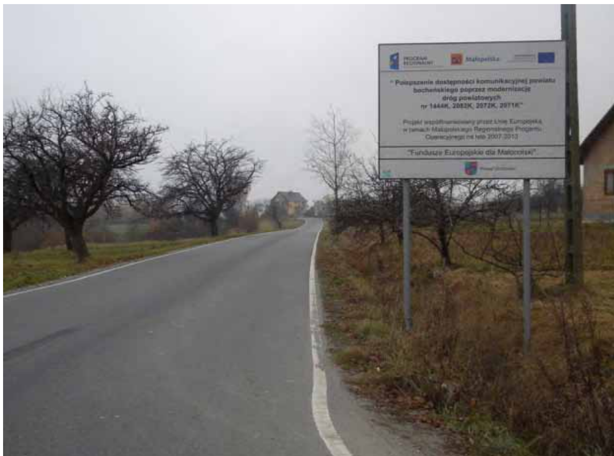
Droga 2072 K w m. Trzciana po przebudowie.
