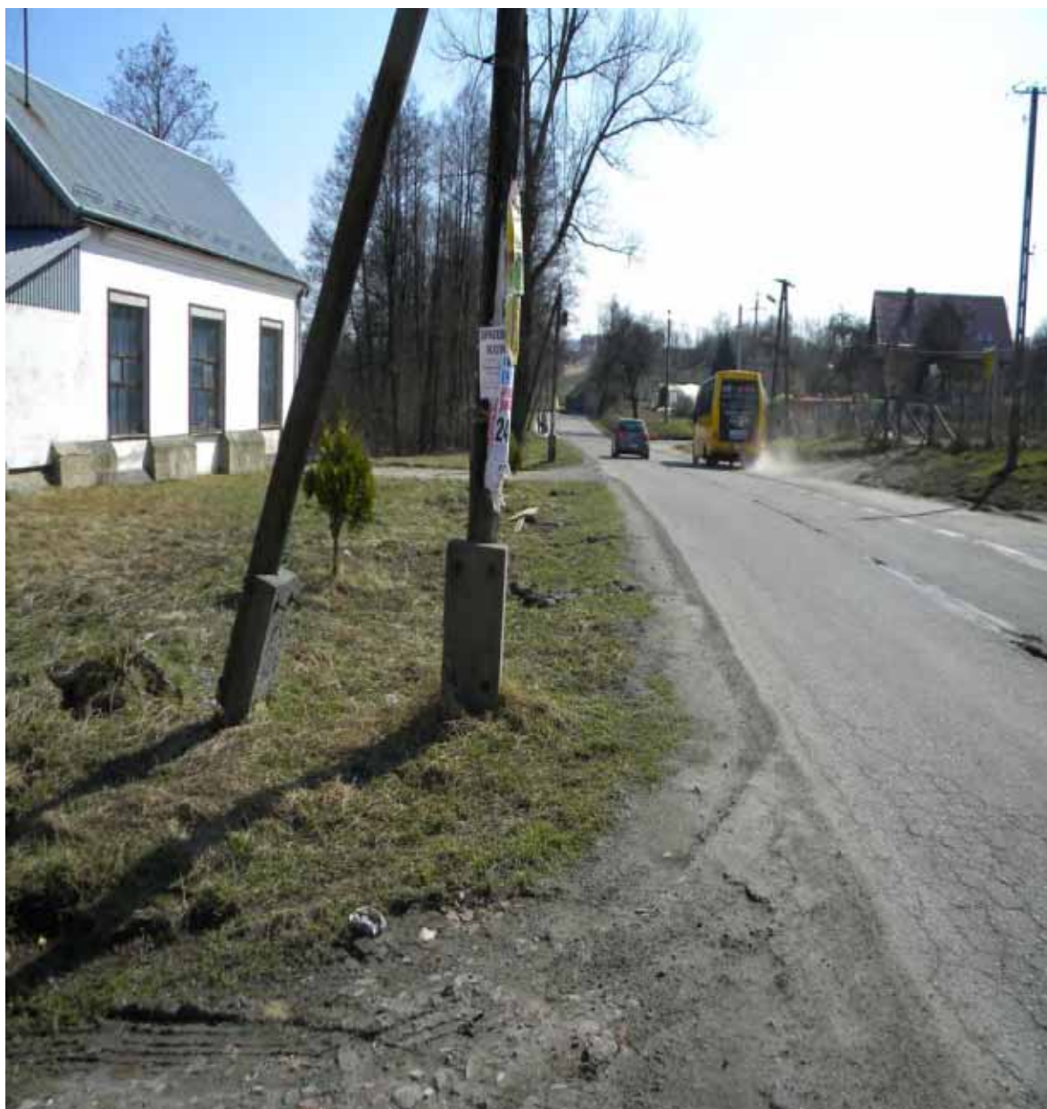
Ulica Lipnicka w Nowym Wiśniczu na której planowany jest odcinek chodnika (lewa strona drogi)
