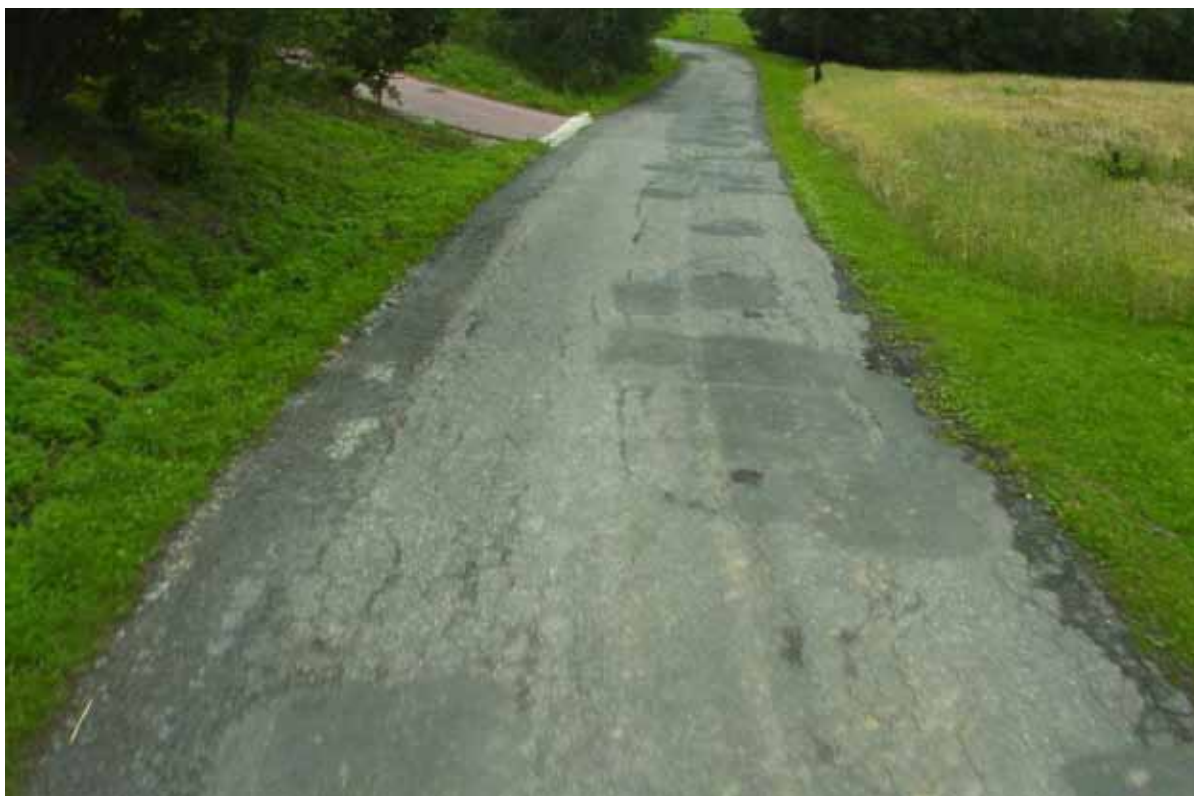
Remont drogi powiatowej nr 2017K Brzezie – Marszowice – Łapanów w msc. Kobylec w km. 2+330 – 3+ 010 - przed wykonywaniem
