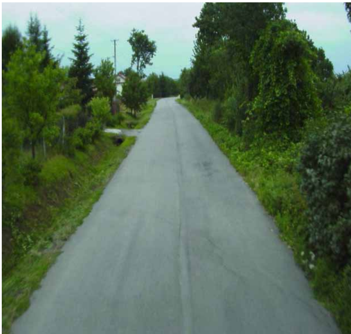
Droga powiatowa nr 2071 K, km 5+200, lokalizacja osuwiska: Ujazd II
