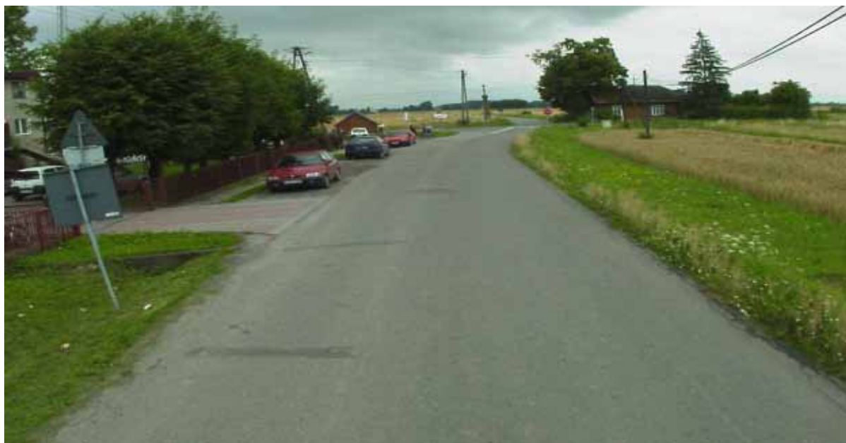
Koniec zakresu robót; km 4+720
