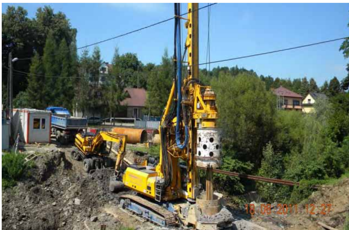
Budowa nowego mostu-wiercenie otworów pod pale.
