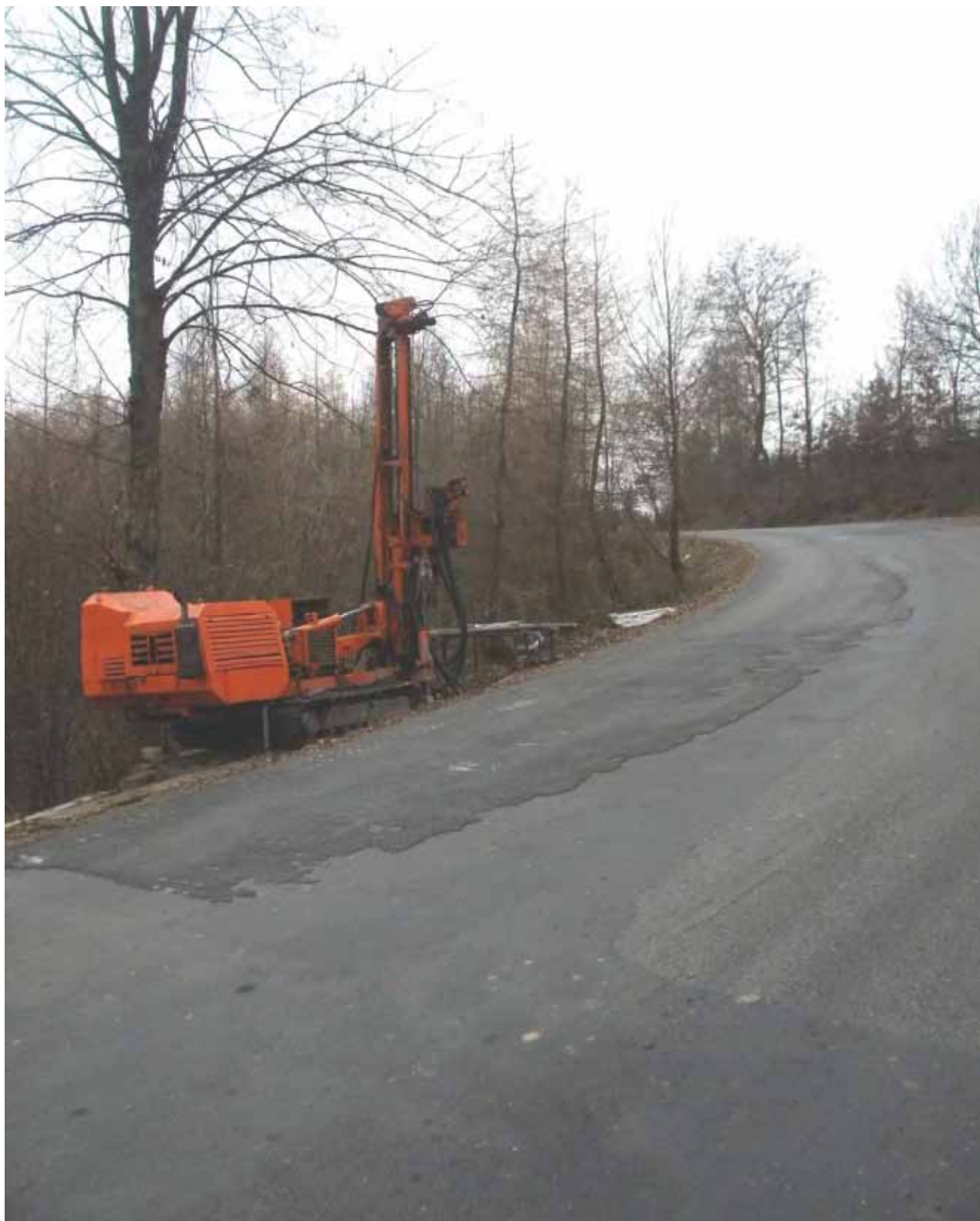
Droga powiatowa nr 1444 K, km 16+980, badania geologiczne na terenie osuwiska Sobolów
