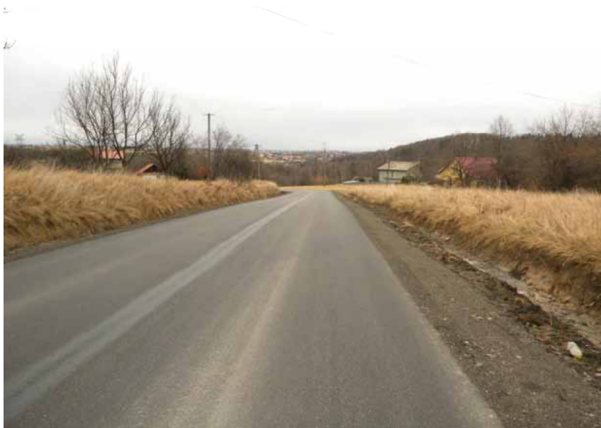
Remont drogi powiatowej nr 2086K Bochnia – Zawada w msc. Pogwizdów w km. 2+746 – 3+040 – po wykonywaniu
