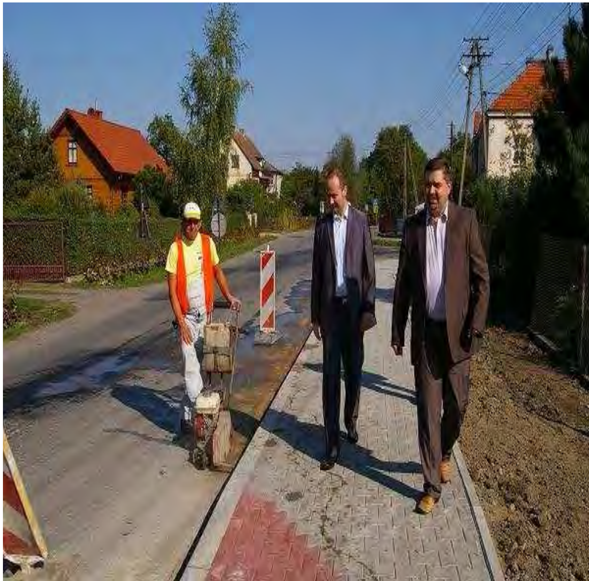
Budowa chodnika w ciągu drogi nr 1424K Bochnia – Uście Solne – Barczków w m. Gawłów.
