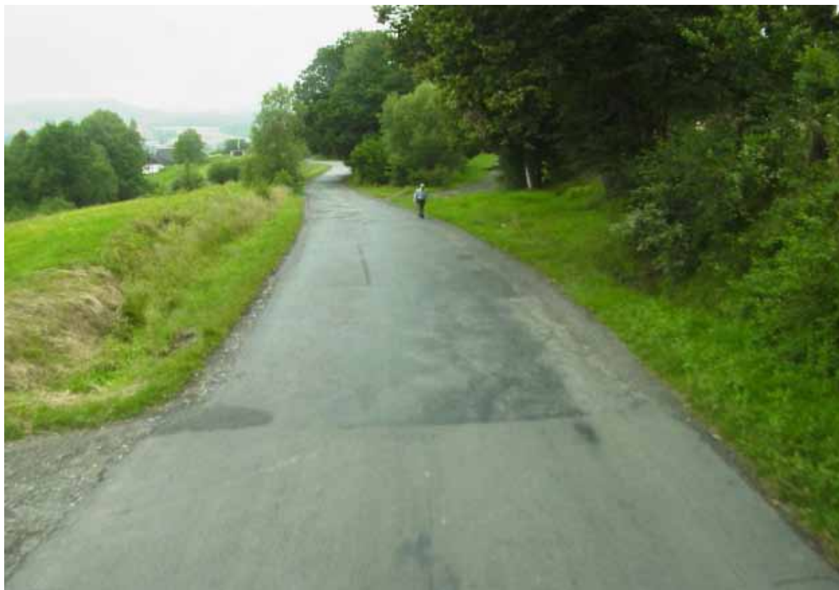
Droga 1444 K w m. Nieszkowice Wielkie przed przebudową.
