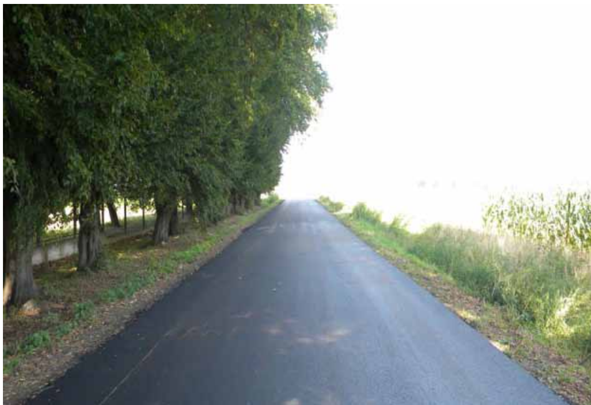
Remont drogi powiatowej nr 2096K Niedary – Gawłówek w km. 2+900 – 3+100 w trakcie wykonywania.
