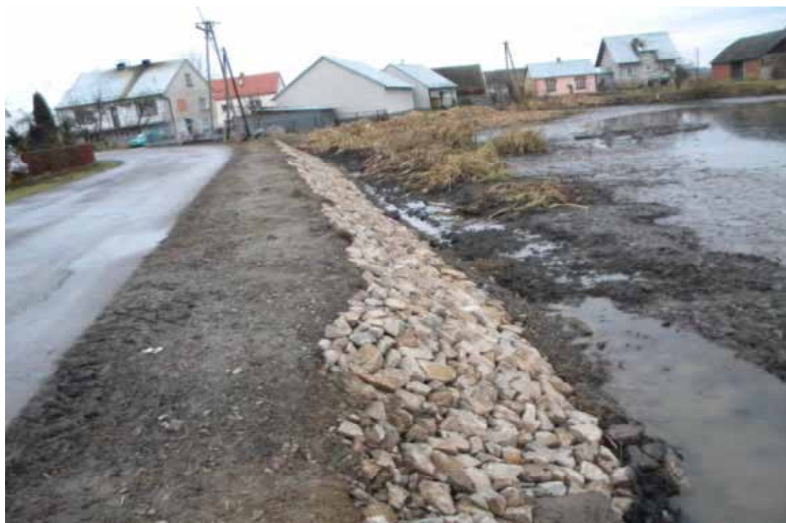
Zabezpieczenie skarpy drogi wzdłuż nr 2097K w msc. Wola Drwińska
