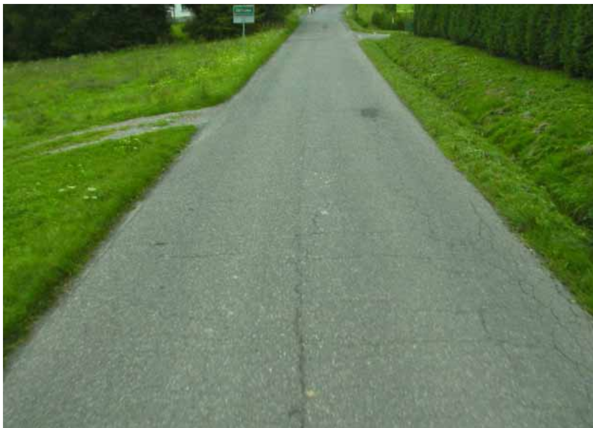
Droga 1444 K m. Olchawa przed przebudową.
