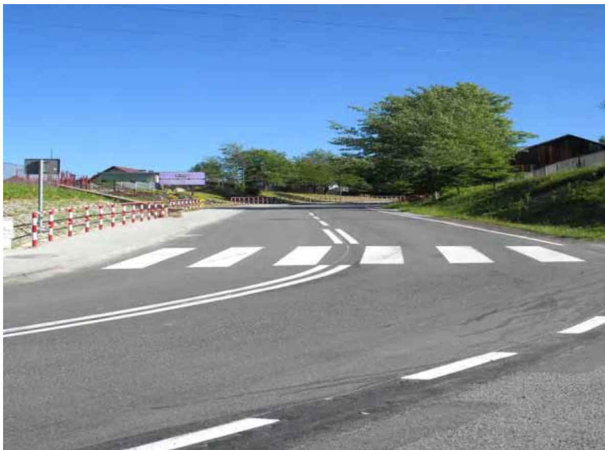
Droga 2072 K w m. Trzciana po przebudowie.
