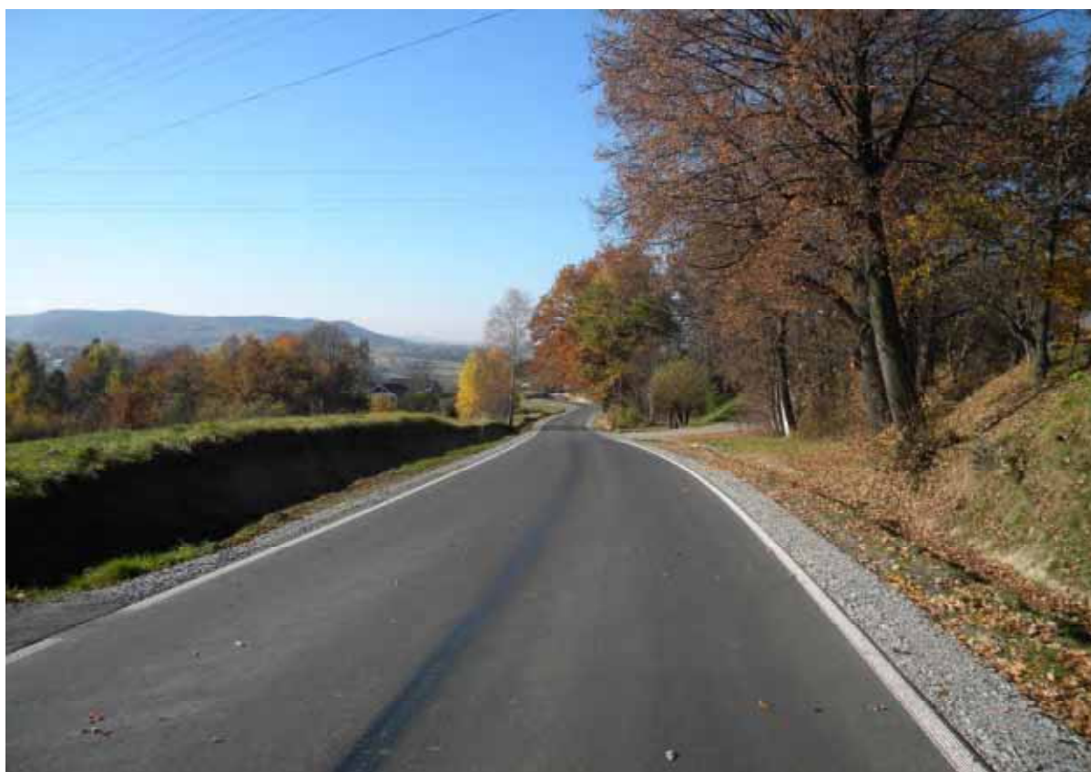
Droga 1444 K w m. Nieszkowice Wielkie po przebudowie
