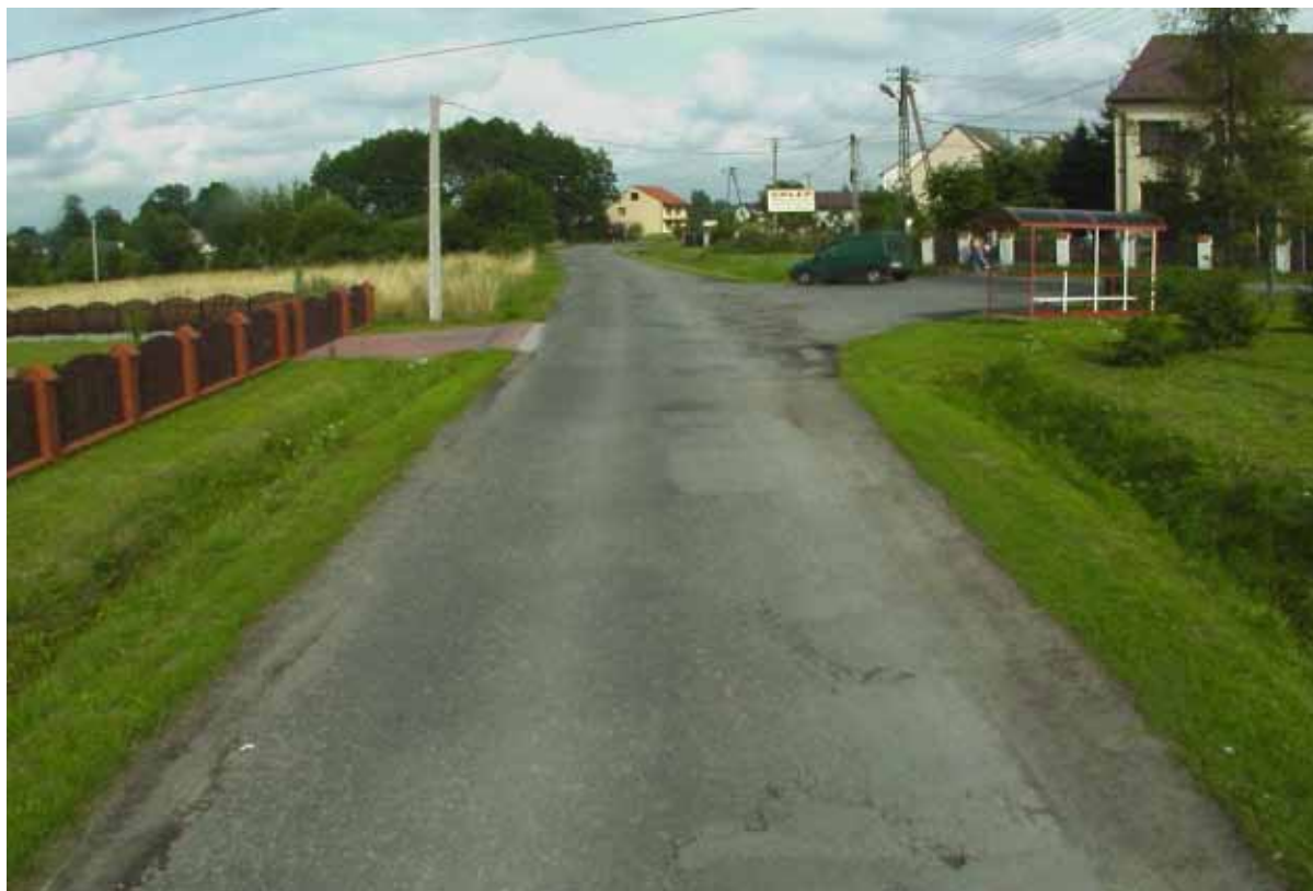
Remont drogi powiatowej nr 2090K Ostrów Królewski – Borek w km 3+300 – 3+600 w msc. Borek - przed wykonaniem.
