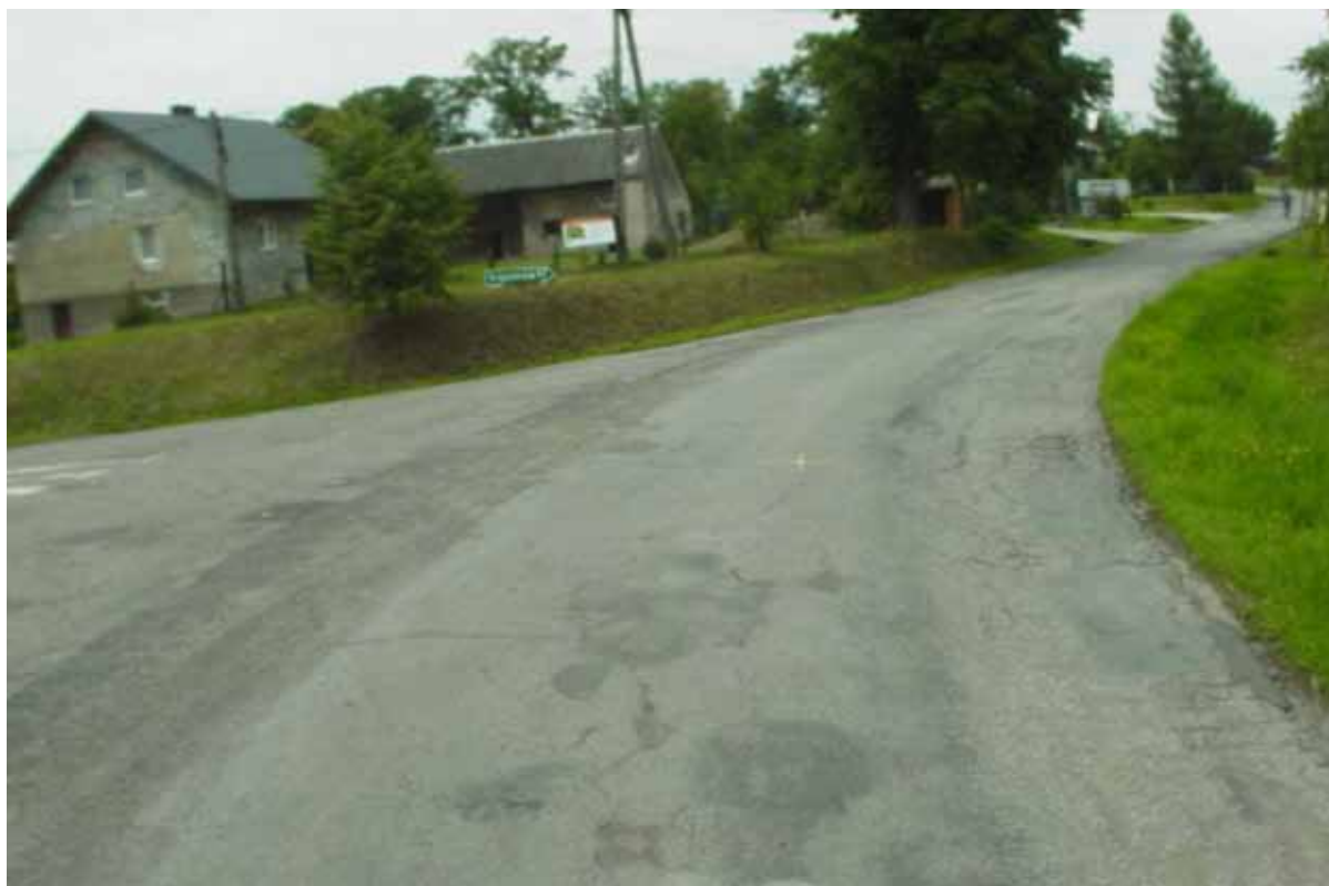
Droga 1444 K w m. Zawada przed przebudową.
