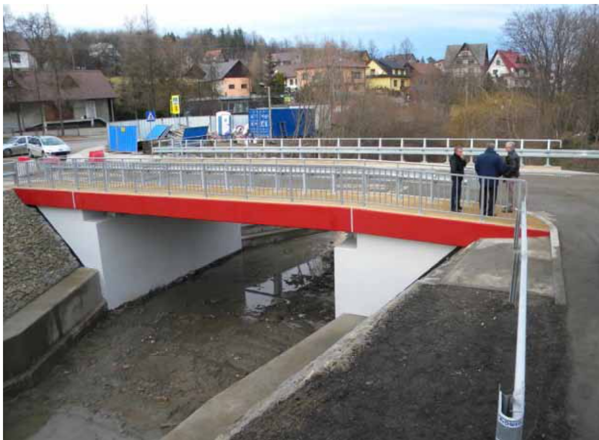
Nowy most w ciągu drogi powiatowej nr 2075 K w Żegocinie
