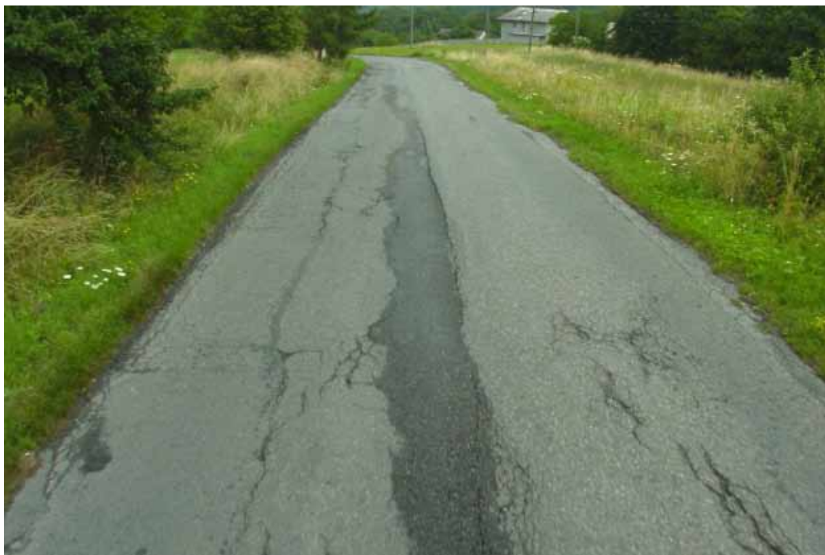
Remont drogi powiatowej nr 2086K Bochnia – Zawada w msc. Pogwizdów w km. 2+746 – 3+040 - przed wykonywaniem.
