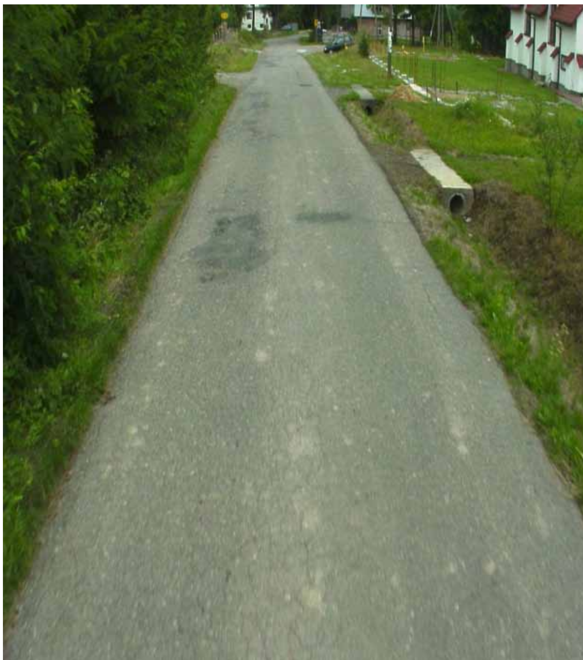
Miejsce planowanego chodnika, parkingu i zatoki autobusowej (strona prawa zdjęcia) 2078 K
