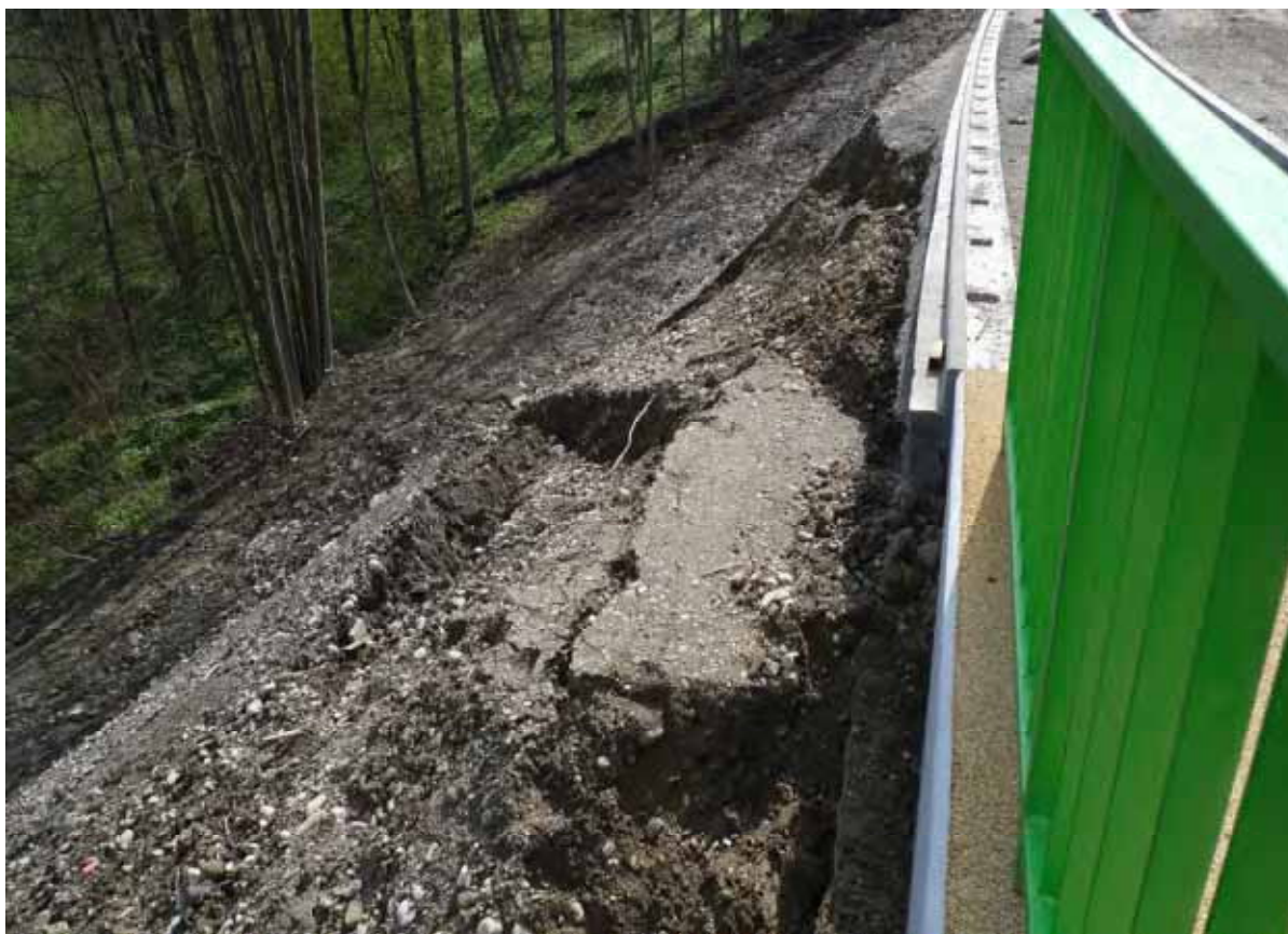
Zabezpieczenie i umocnienie nasypu skarpy przy drodze powiatowej nr 2072K Leszczyna – Nowe Rybie w msc. Kamionna .
