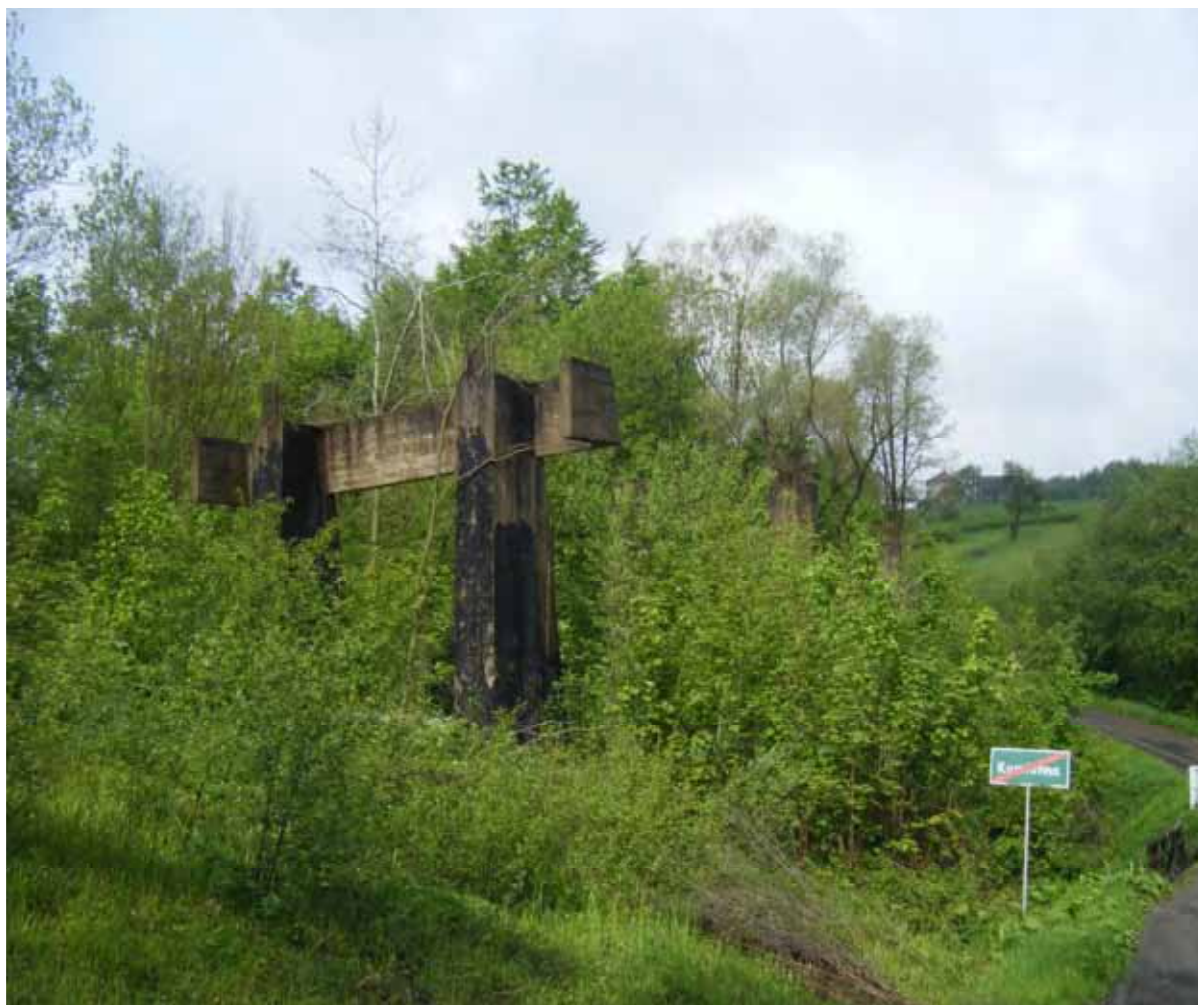
Podpory planowanego mostu z lat siedemdziesiątych ubiegłego wieku.
