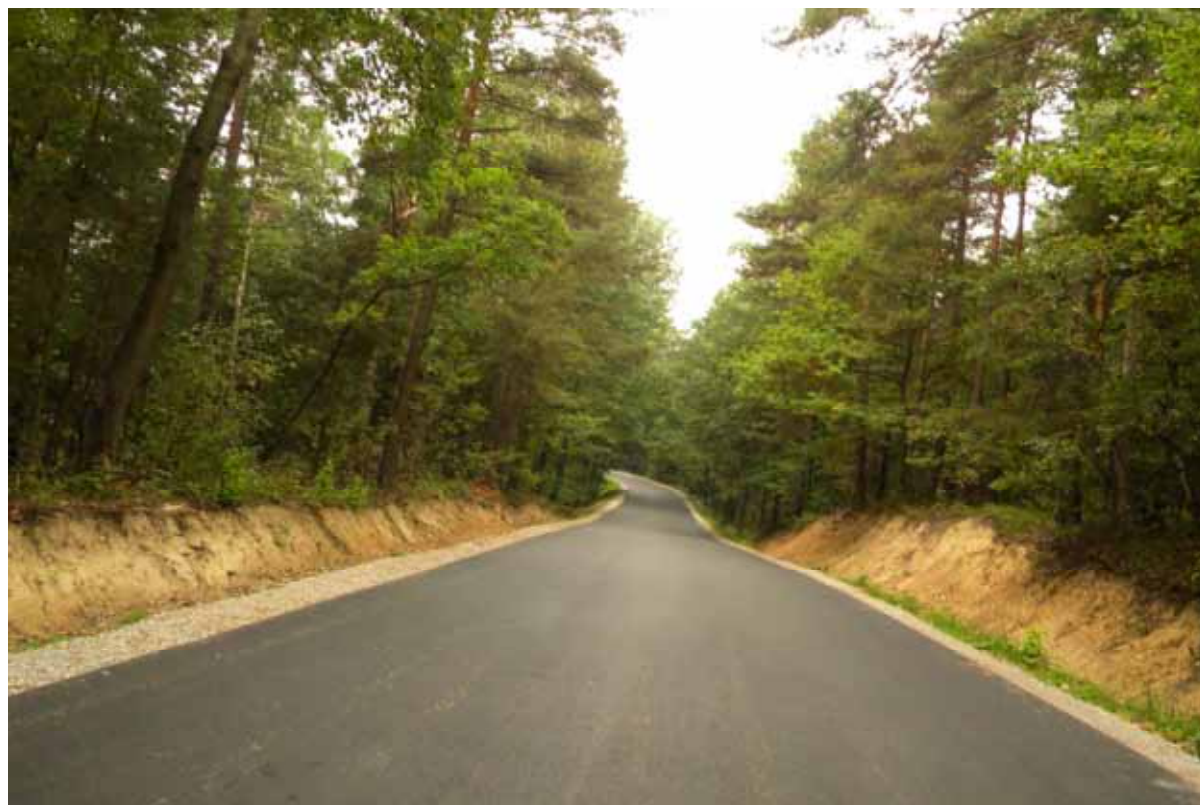
Remont drogi powiatowej nr 1446K Muchówka-Porąbka Iwkowska w km. 0+200 – 2+300 – po wykonaniu
