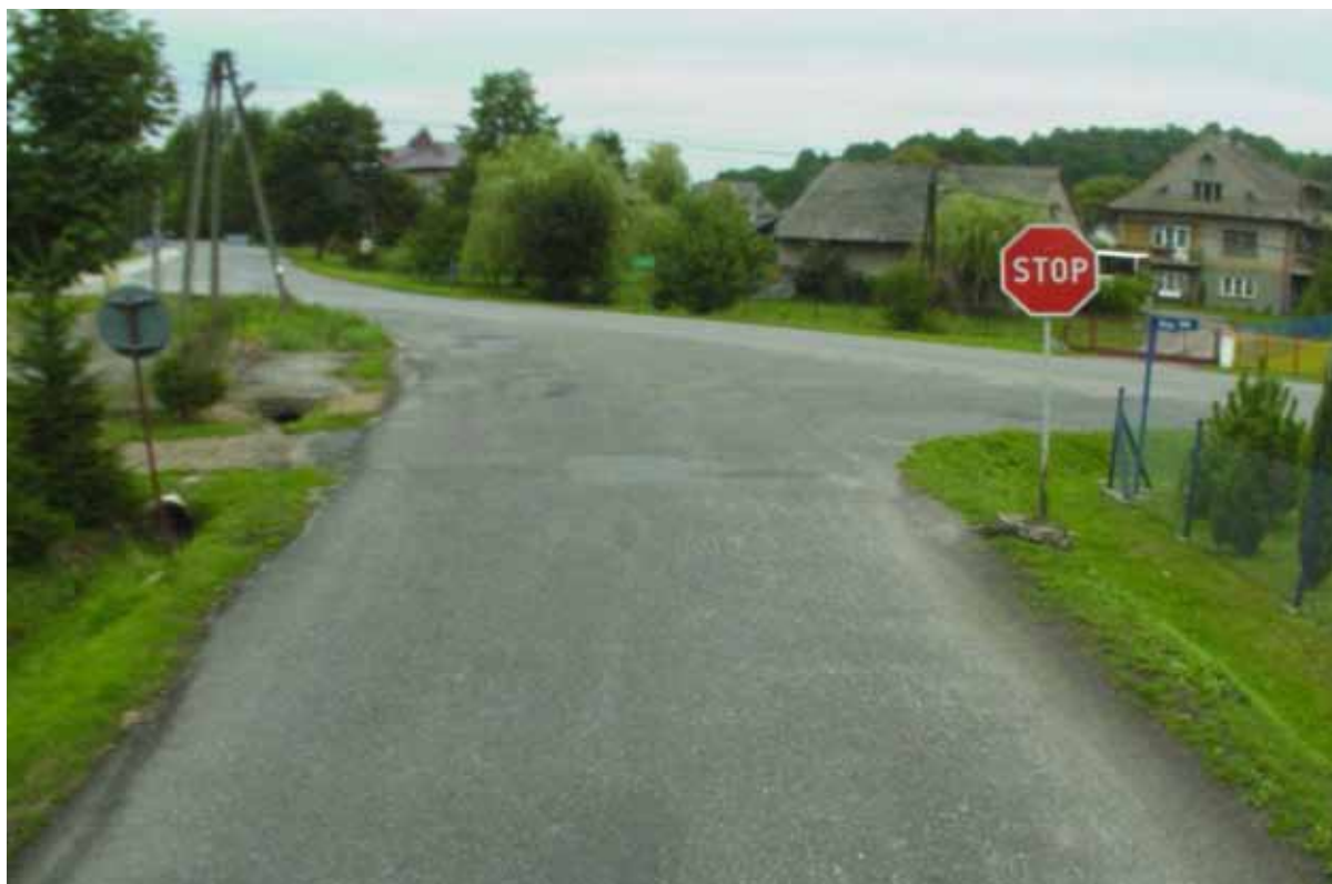
Koniec projektowanego chodnika ; skrzyżowanie dróg powiatowych nr 2071 K i 1961 K
