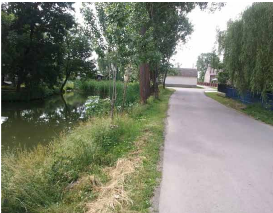
Droga nr 2097K Ispina – Bieńkowice w msc. Wola Drwińska przed zabezpieczeniem skarpy drogi
