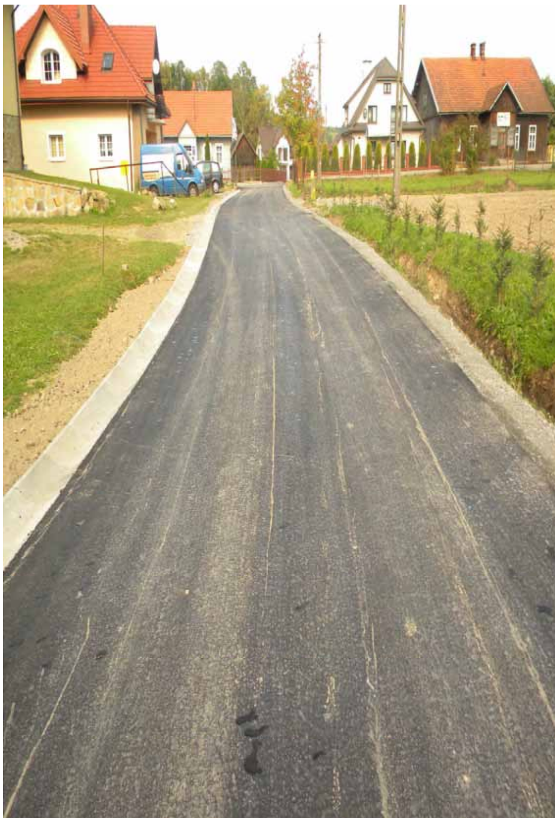
Remont drogi powiatowej nr 1446K Iwkowa - Lipnica Dolna w msc. Lipnica Dolna
