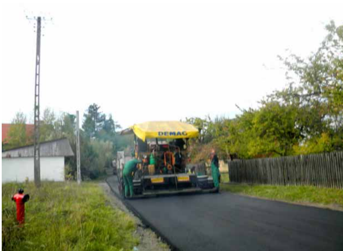
Remont drogi powiatowej nr 2084K Sobolów Zwada w msc. Sobolów/Zonia w km. 2+105 – 2+795 - w trakcie wykonywania
