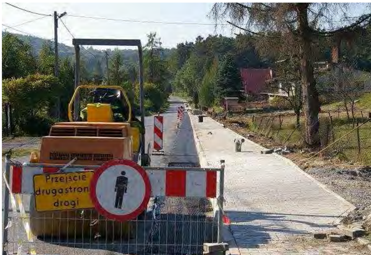
Budowa chodnika w ciągu drogi nr 2086 K Bochnia – Zawada, ul. Strzelecka.
