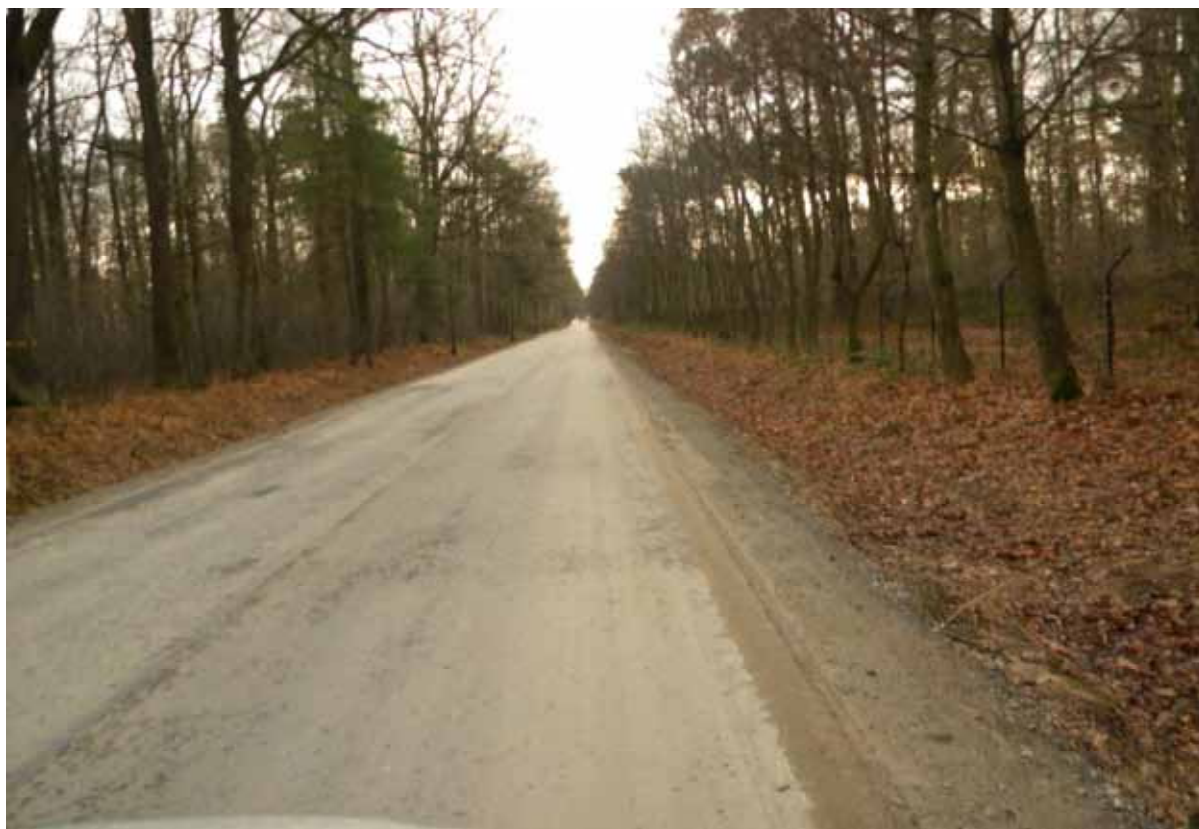
Remont drogi powiatowej nr 1435K Cerekiew – Brzesko w msc. Dąbrówka w km. 9+700 – 10+100 – po wykonaniu
