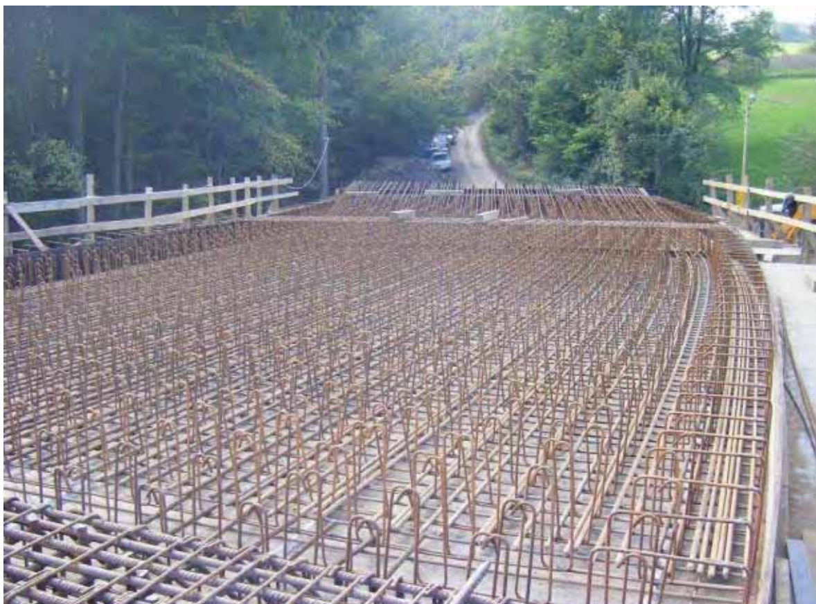
Zbrojenie płyty mostu
