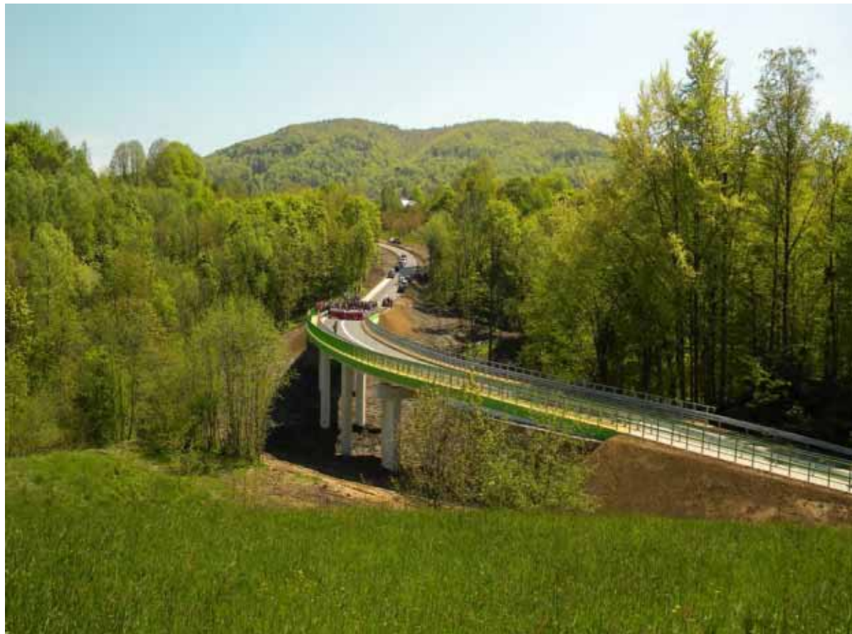
Nowy most w ciągu drogi powiatowej nr 2072 K w Kamionej
