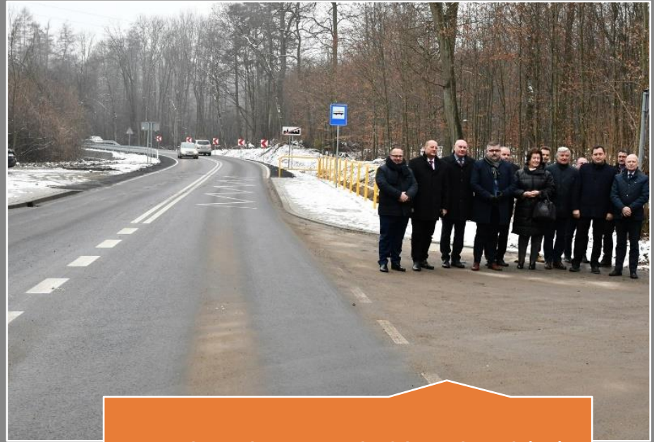
Rozbudowa ul. Strzeleckiej w Bochni
